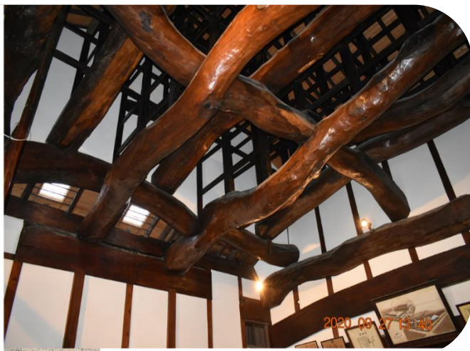
④④ 豊村酒造とその土間の天井の見得の梁
