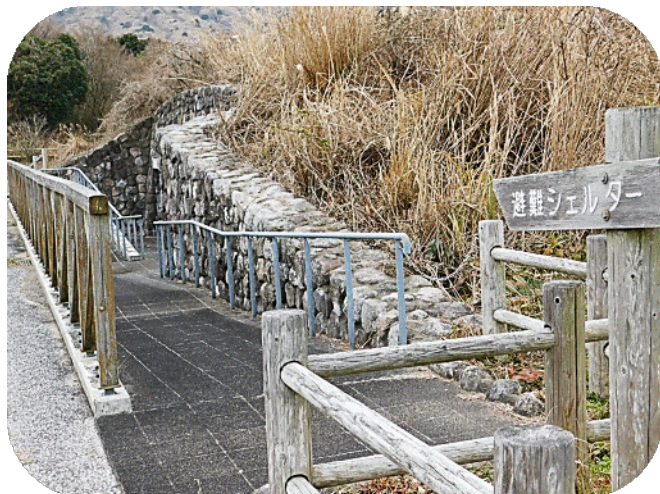
ネイチャーセンターの避難シェルター
