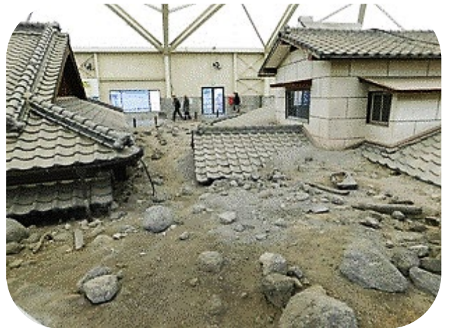
土石流に埋まった家屋 (保存公園)
