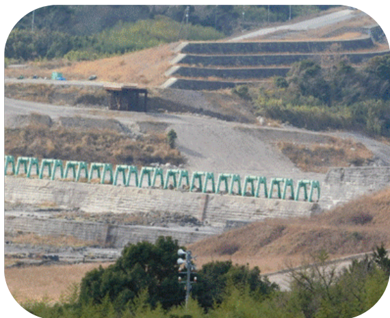
無人施工の水無川のスリット（左）と砂防堰堤
