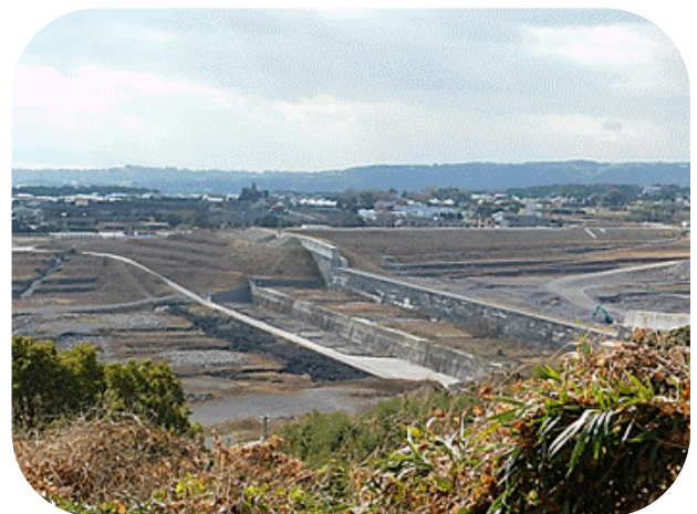
無人施工の水無川のスリット（左）と砂防堰堤
